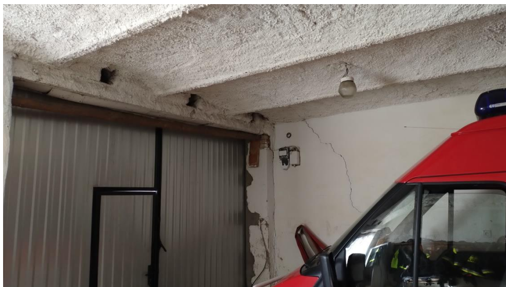
Fot. 3 – Widok zarysowanej ściany w pomieszczeniu OSP
